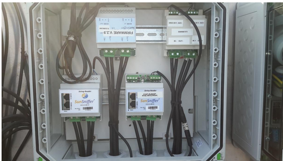
图例 10：防水外盒中的串组读取器和与之相连的 RS485 数据线
