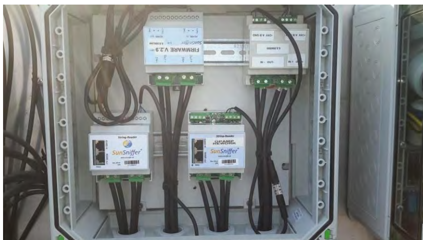
Abbildung 10: String Reader verbunden über RS-485 Datenkabel in einem wasserdichten Gehäuse.
